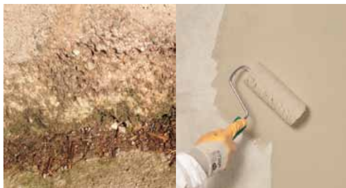
Beton po 12 měsíčním působení silážních šťáv
